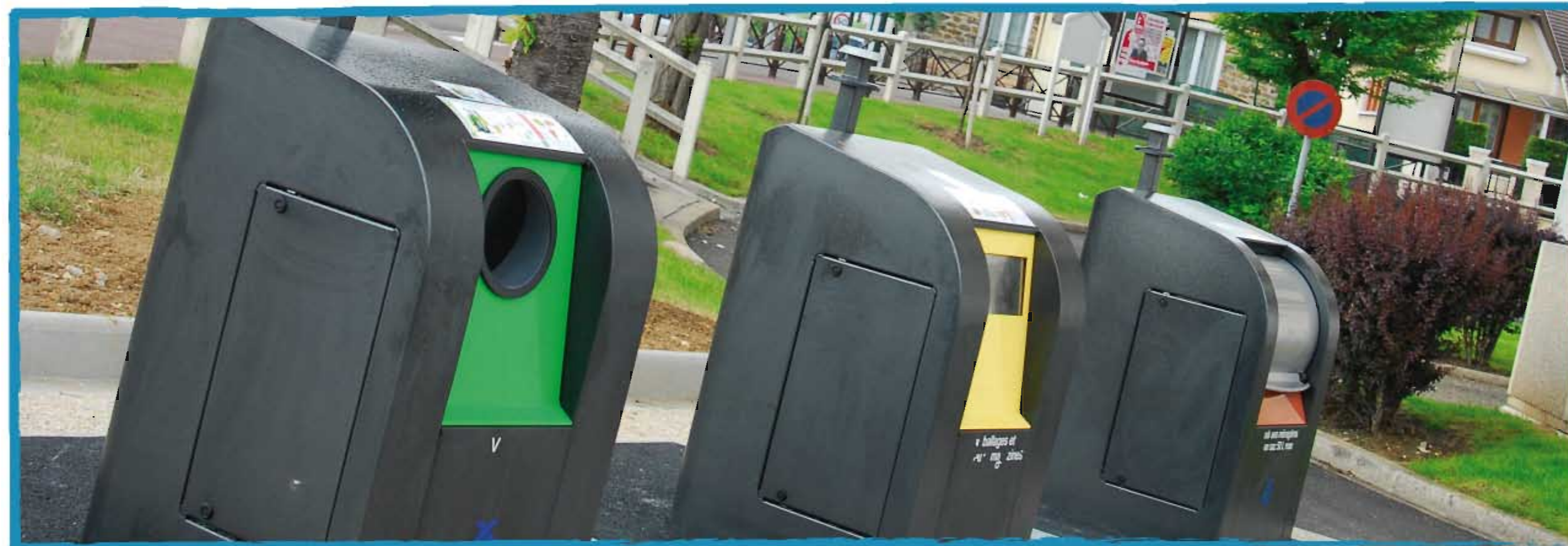
Bornes enterrées pour le tri des déchets
