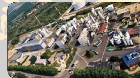
Site de SARP INDUSTRIES à Limay 78
